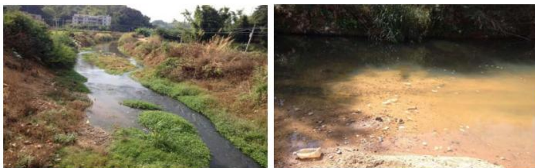
桥头水河源市段河道现状图
