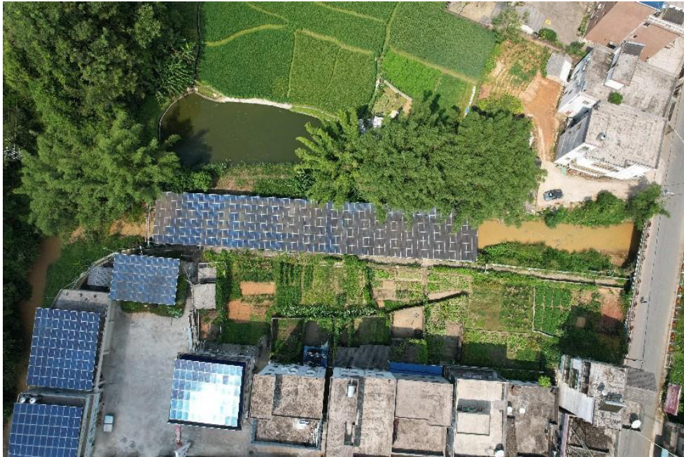
违规建筑侵占河道
