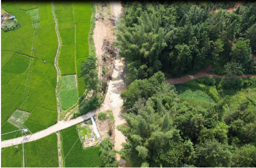
树木堆占河道
